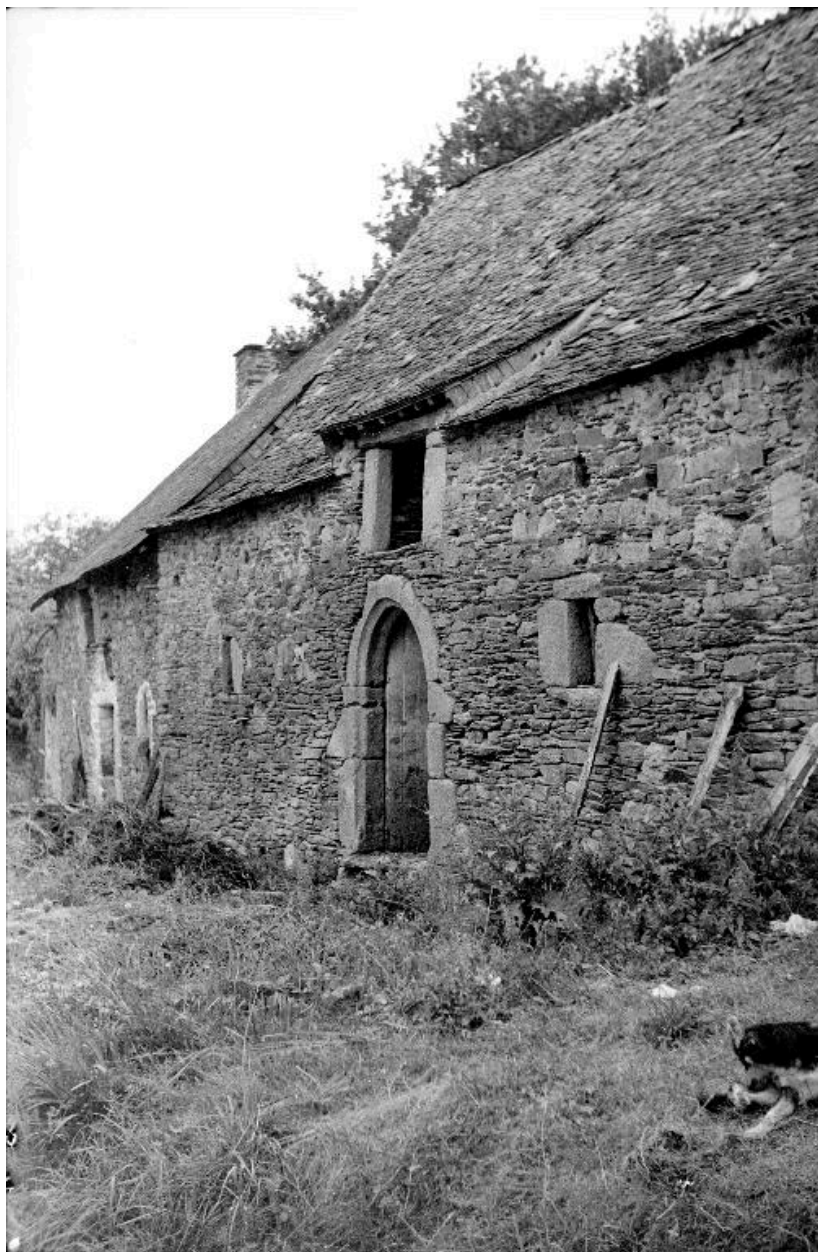
Ferme 32 (état en 1969)
