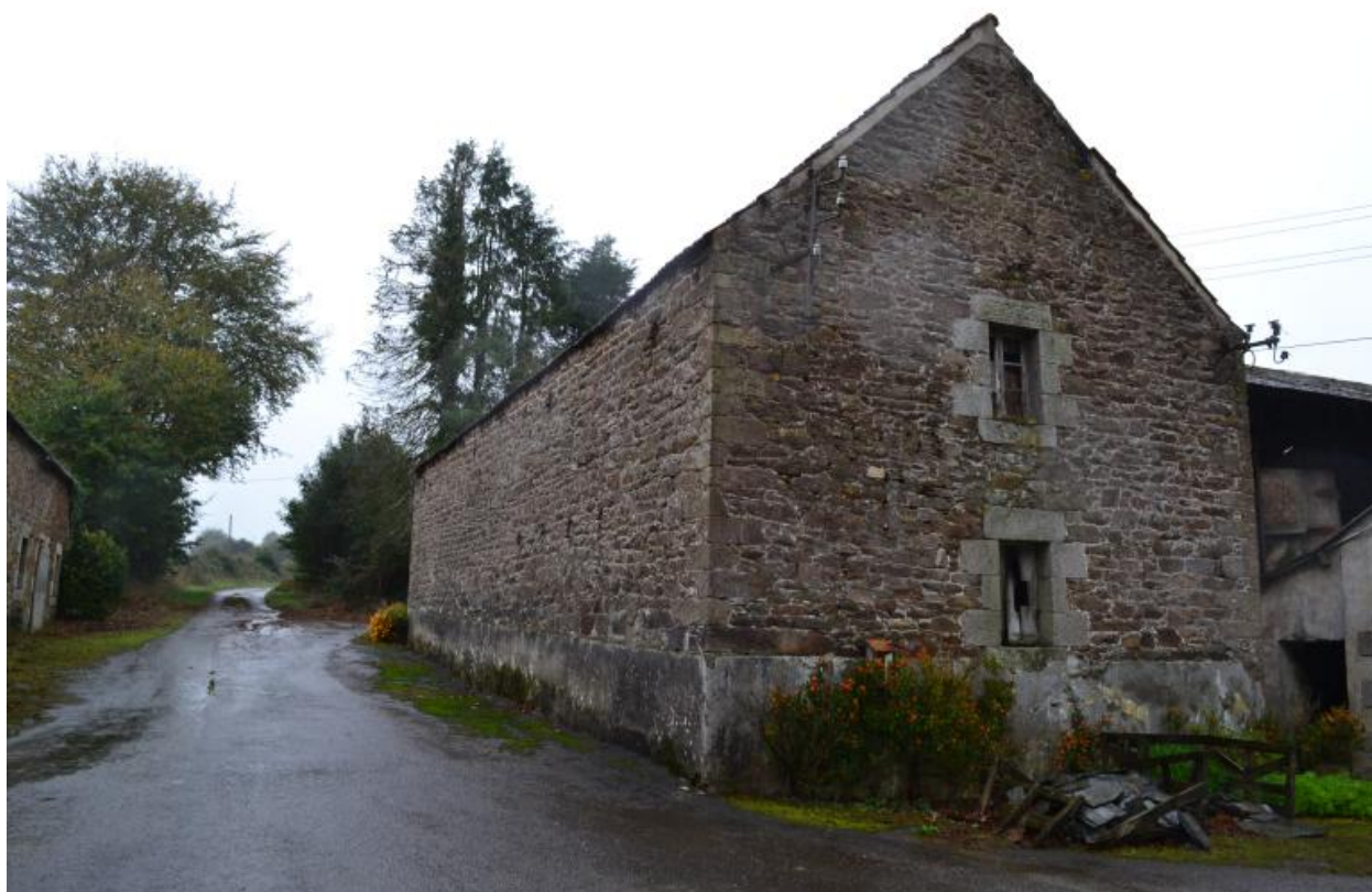
Grange, 1864. Vue générale sud-est
