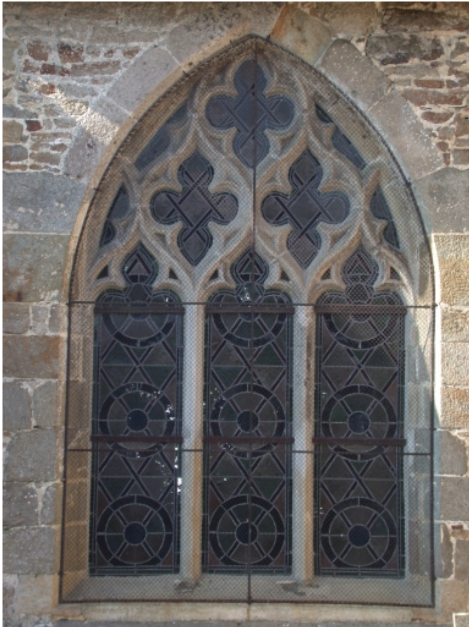
Chapelle sud, mur est, (baie 4)
