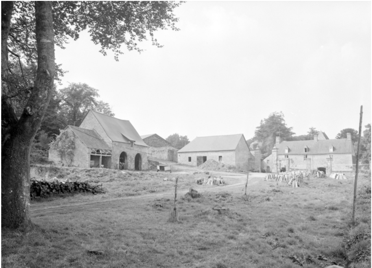
MALGUENAC, Lesturgant, manoir (actuellement château), manoir et communs, vue générale sud.
