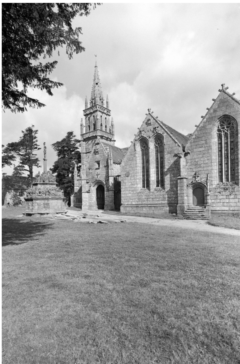
Vue de situation rapprochée prise du sud est
