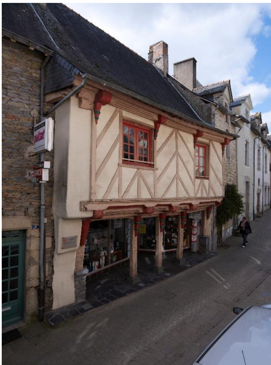
Maison : élévation principale vue de l'est (état en 2012)
