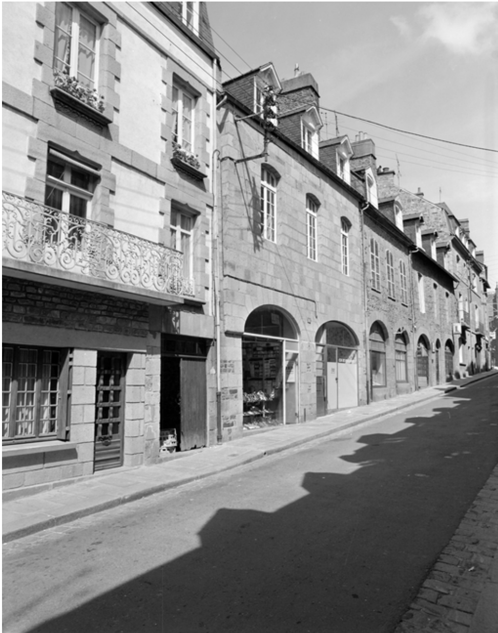
18 rue de la Pinterie, vue générale sud-ouest..
