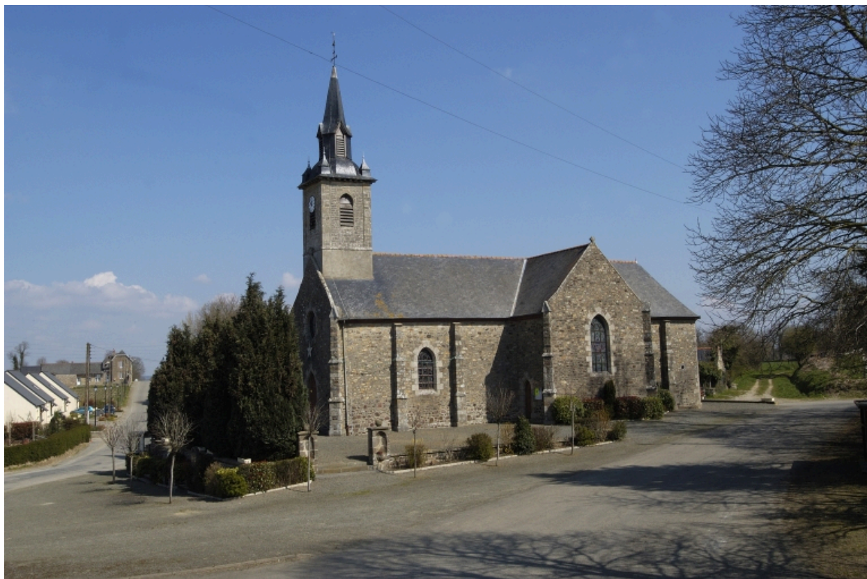
Vue générale, façade Sud
