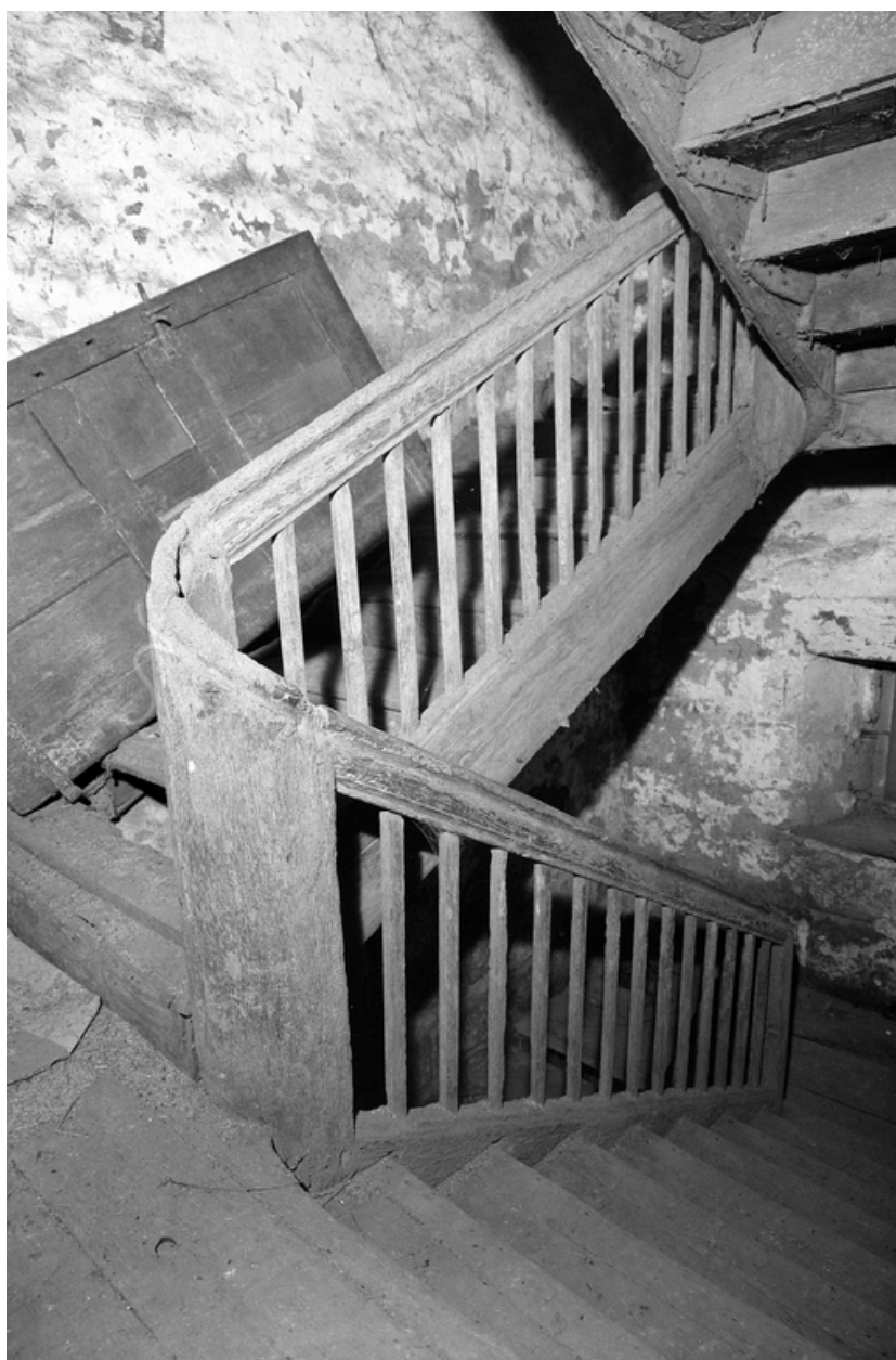
Escalier : vue prise du 1er étage
