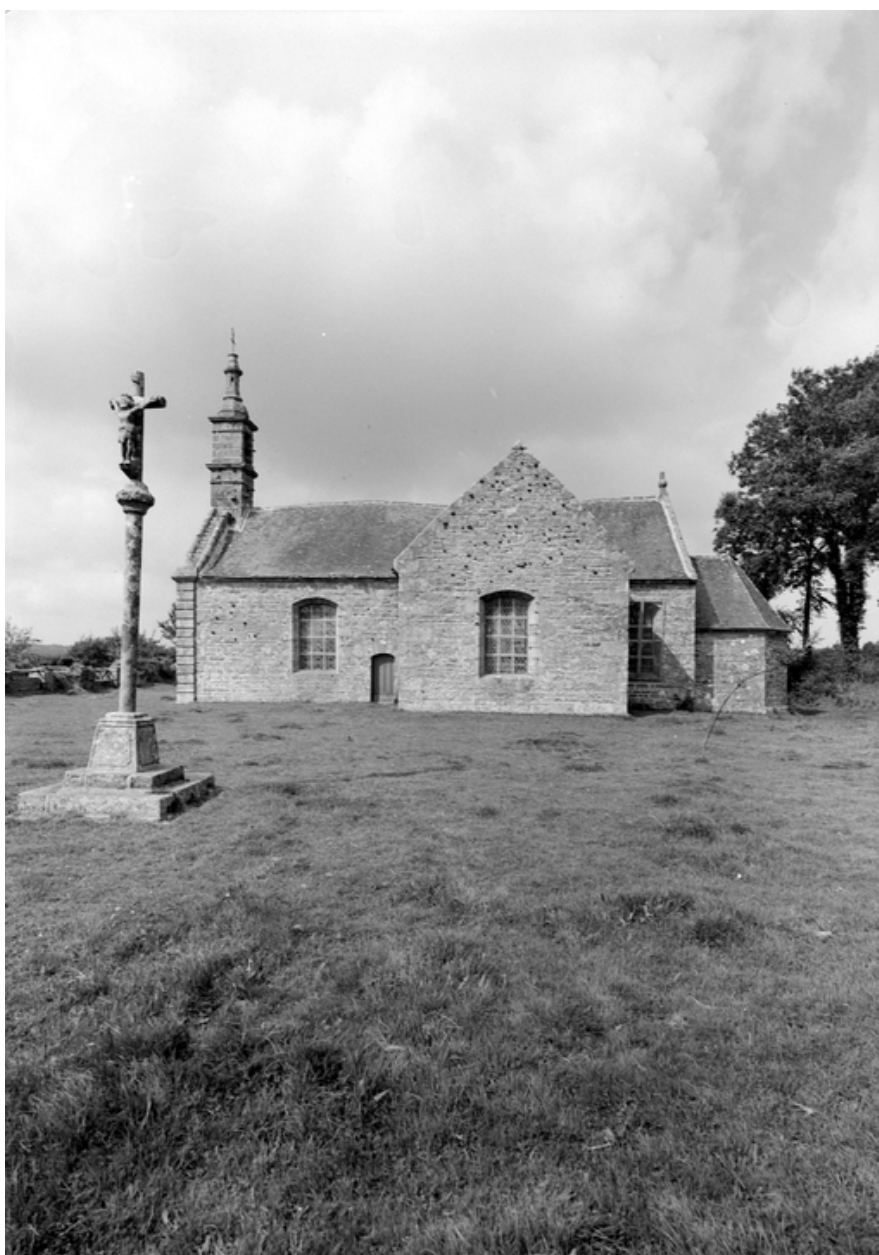
Vue de la façade sud
