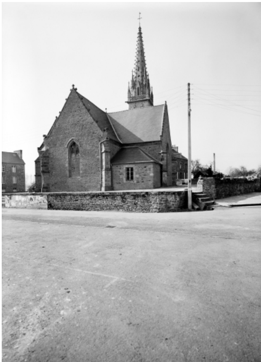
Elévation Est : vue générale
