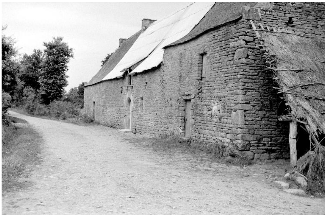
Ferme 44 (état en 1969)
