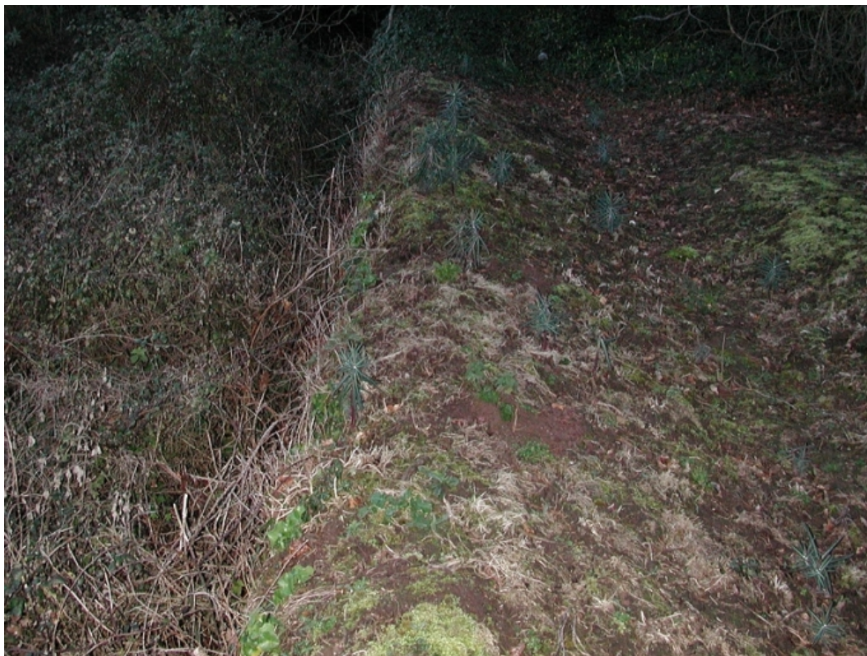
Vue générale d'un muret sous la végétation
