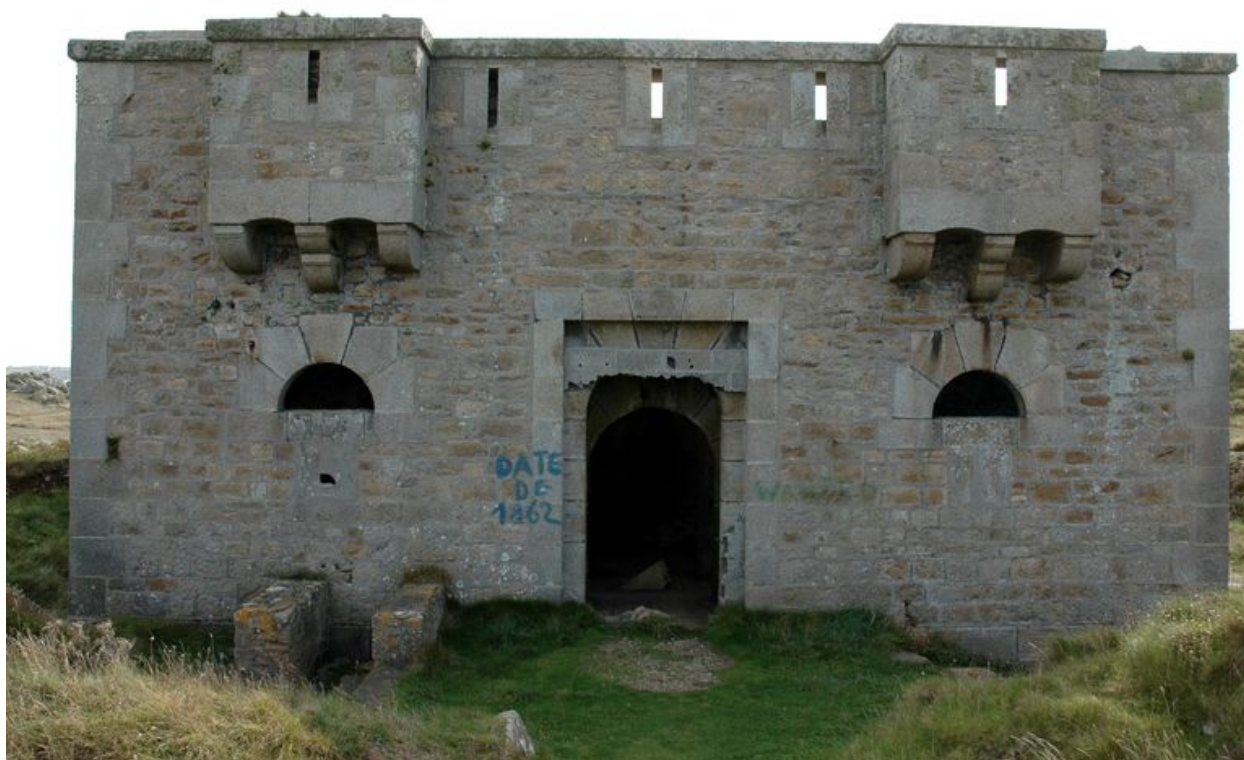
Vue du réduit de batterie de côte de Loqueltas, façade septentrionale
