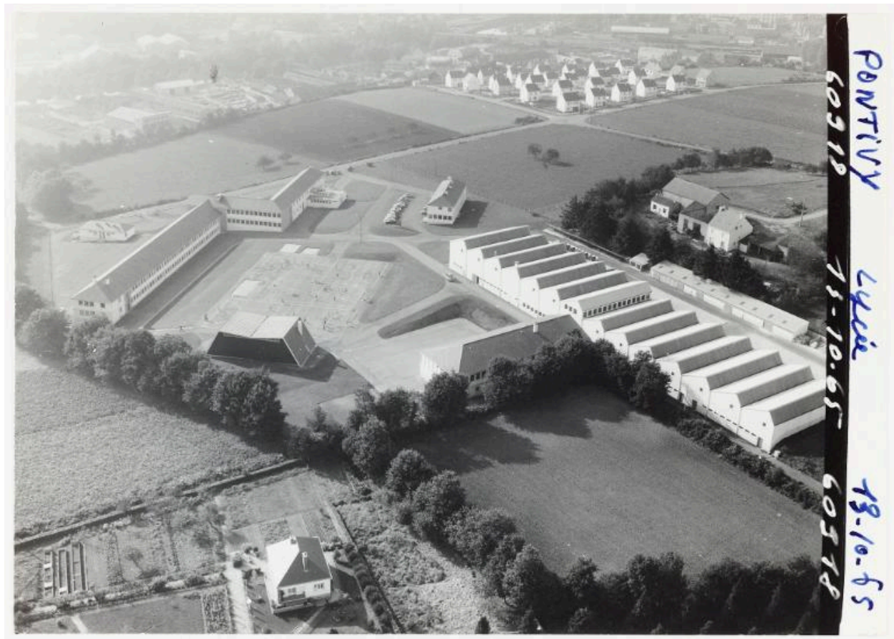
Vue aérienne Heurtier prise de l'est, octobre 1965.
