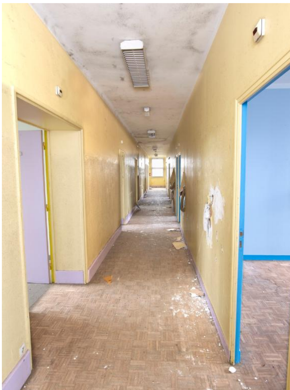
Couloir de desserte central, internat de garçons (1954) désaffecté.
