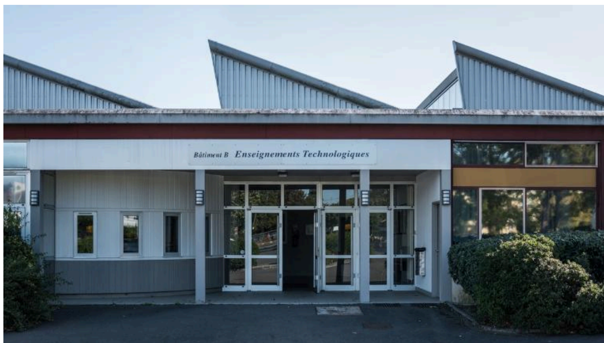
Bâtiment B, ateliers, détail sur l'entrée en façade ouest. Louis Arretche et Jean Monge, architectes, plans 1959.
