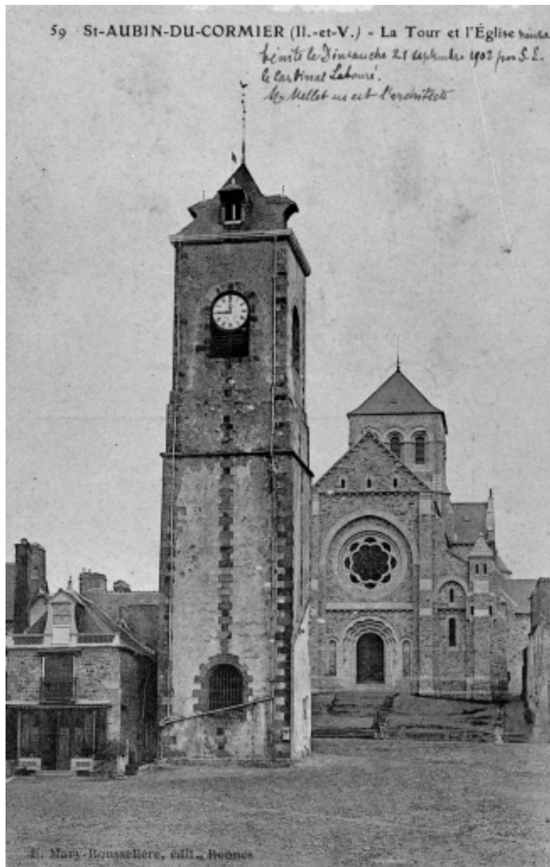
Tour de l'ancienne église et église neuve (repro.carte postale ancienne)
