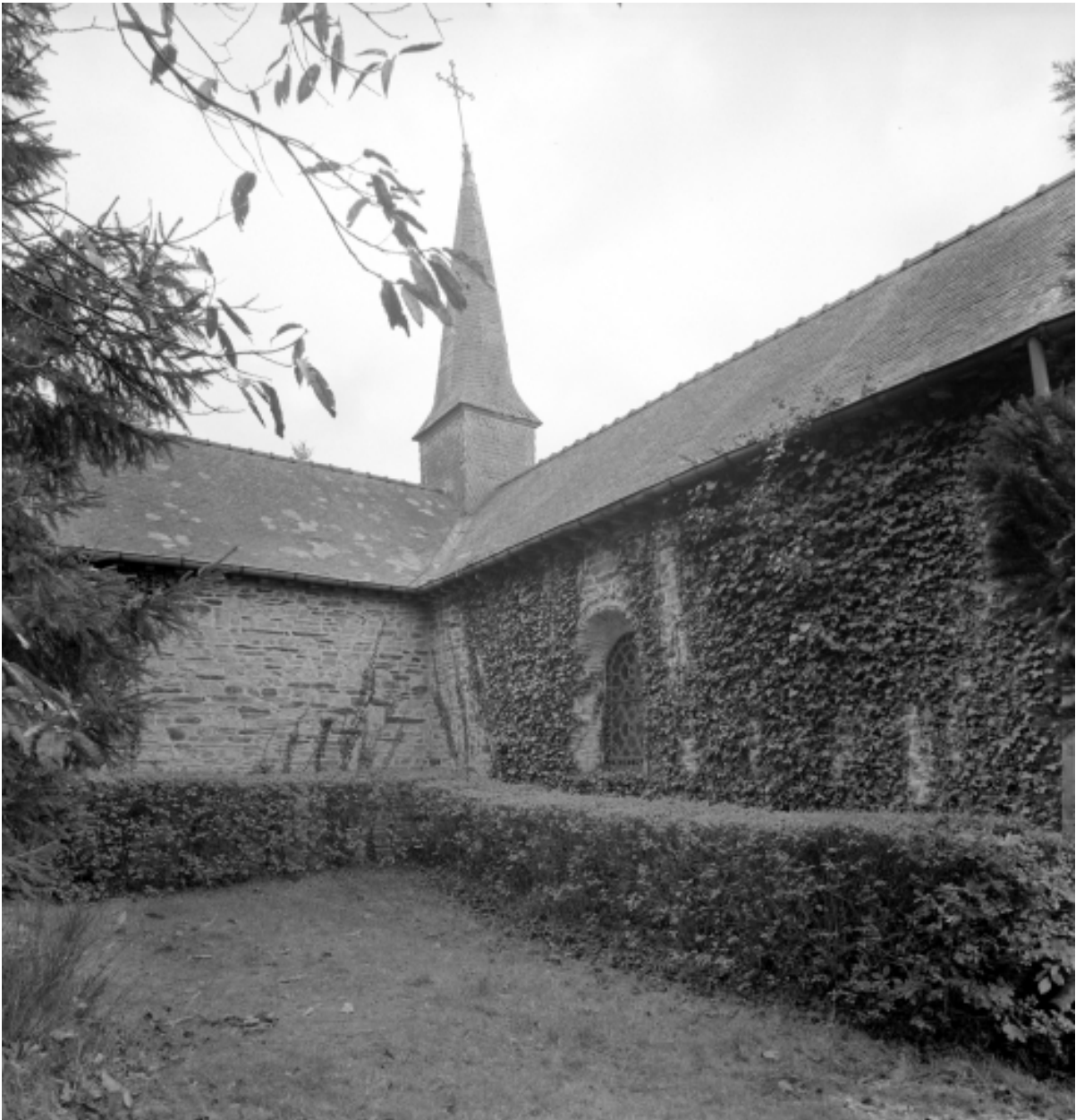
Elévation Nord-Ouest : vue générale
