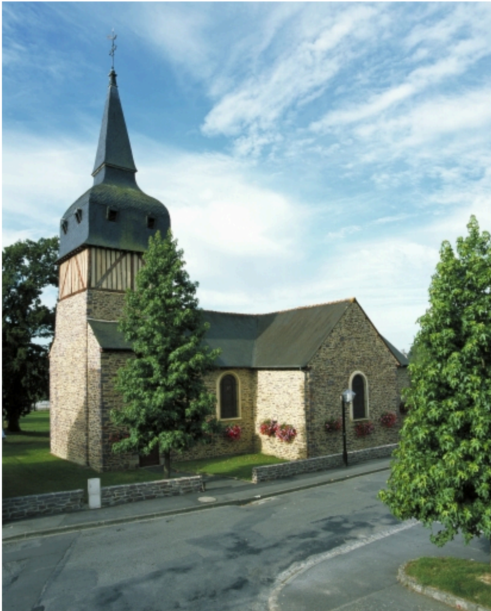
Vue générale nord-est
