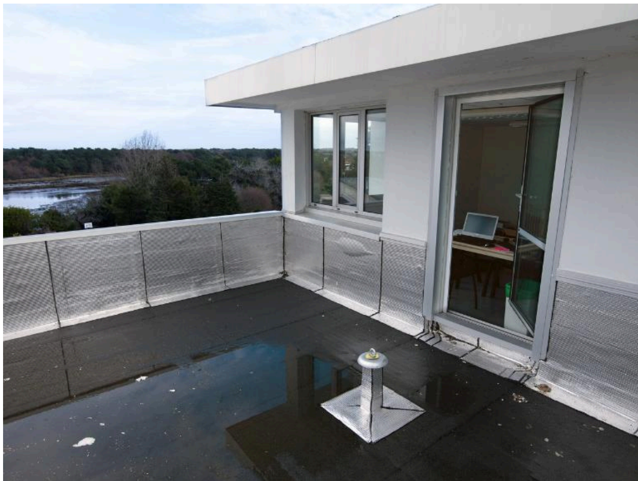
Toit terrasse de la tourelle de l'externat, pris du sud-ouest vers le nord-est.
