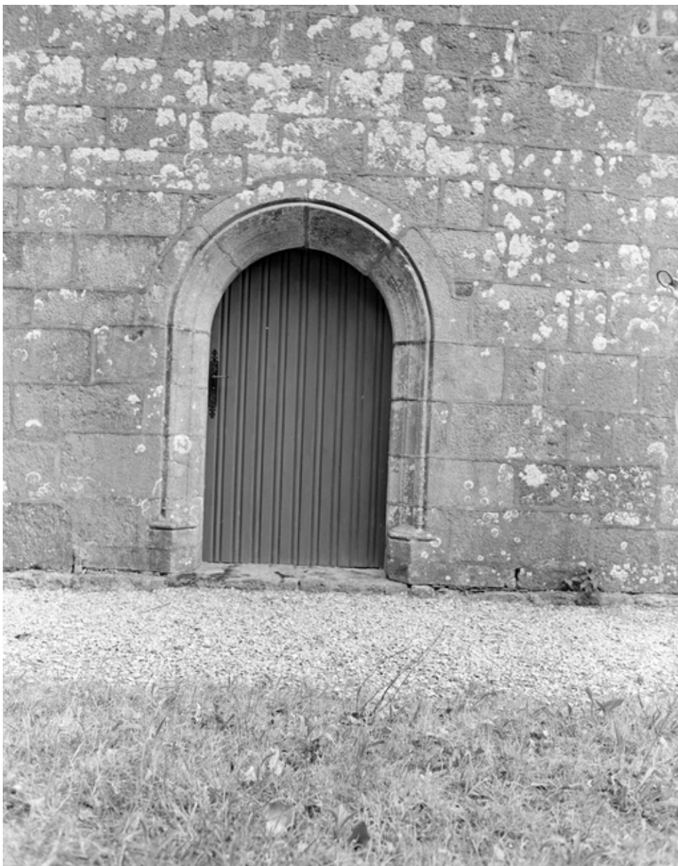
Nef, élévation ouest, porte
