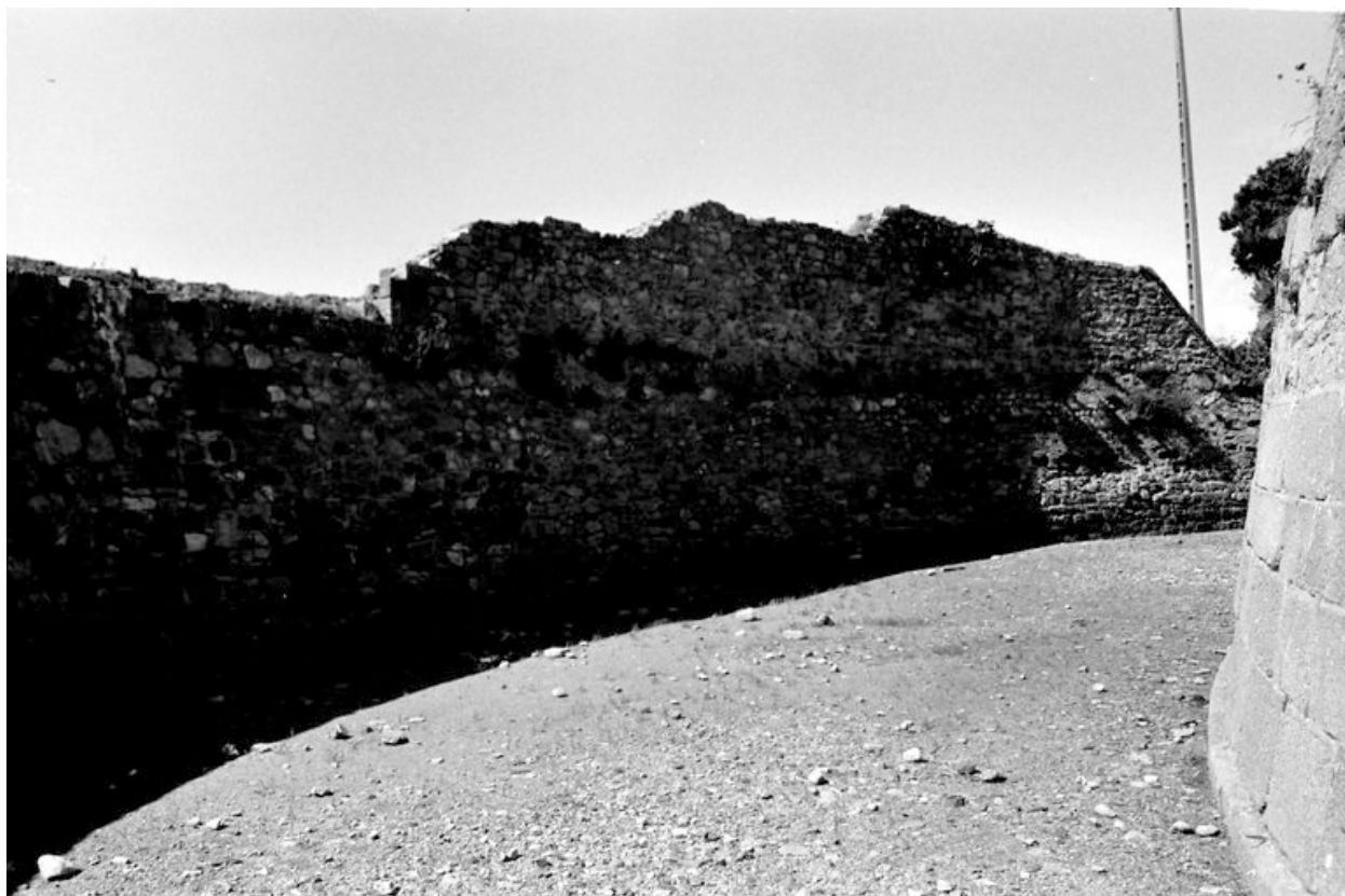
Vue de la tour Vauban en 1967
