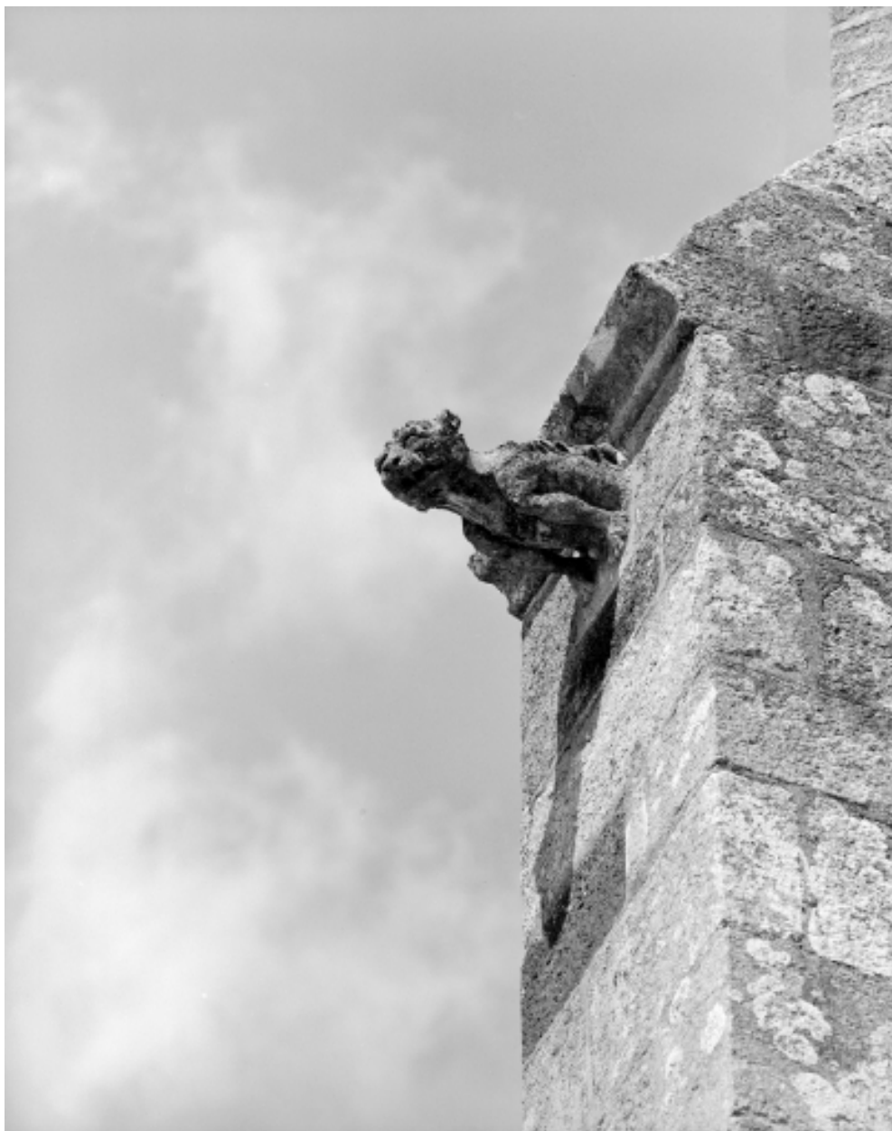
Elévation sud, vue de détail de gargouille.
