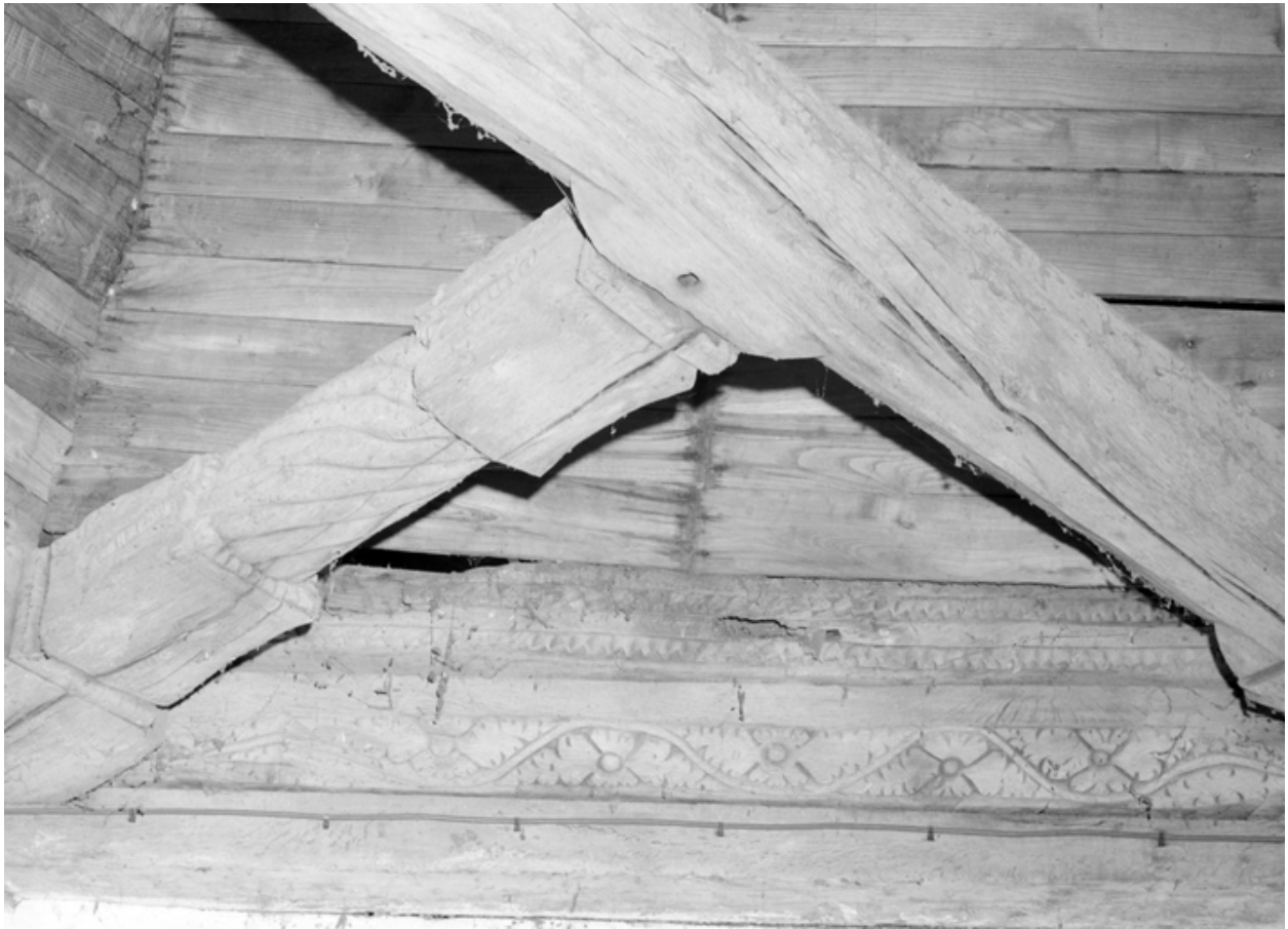
Chapelle : un entrain, deux engoulants et une sablière ornée de végétaux (état en 1984)
