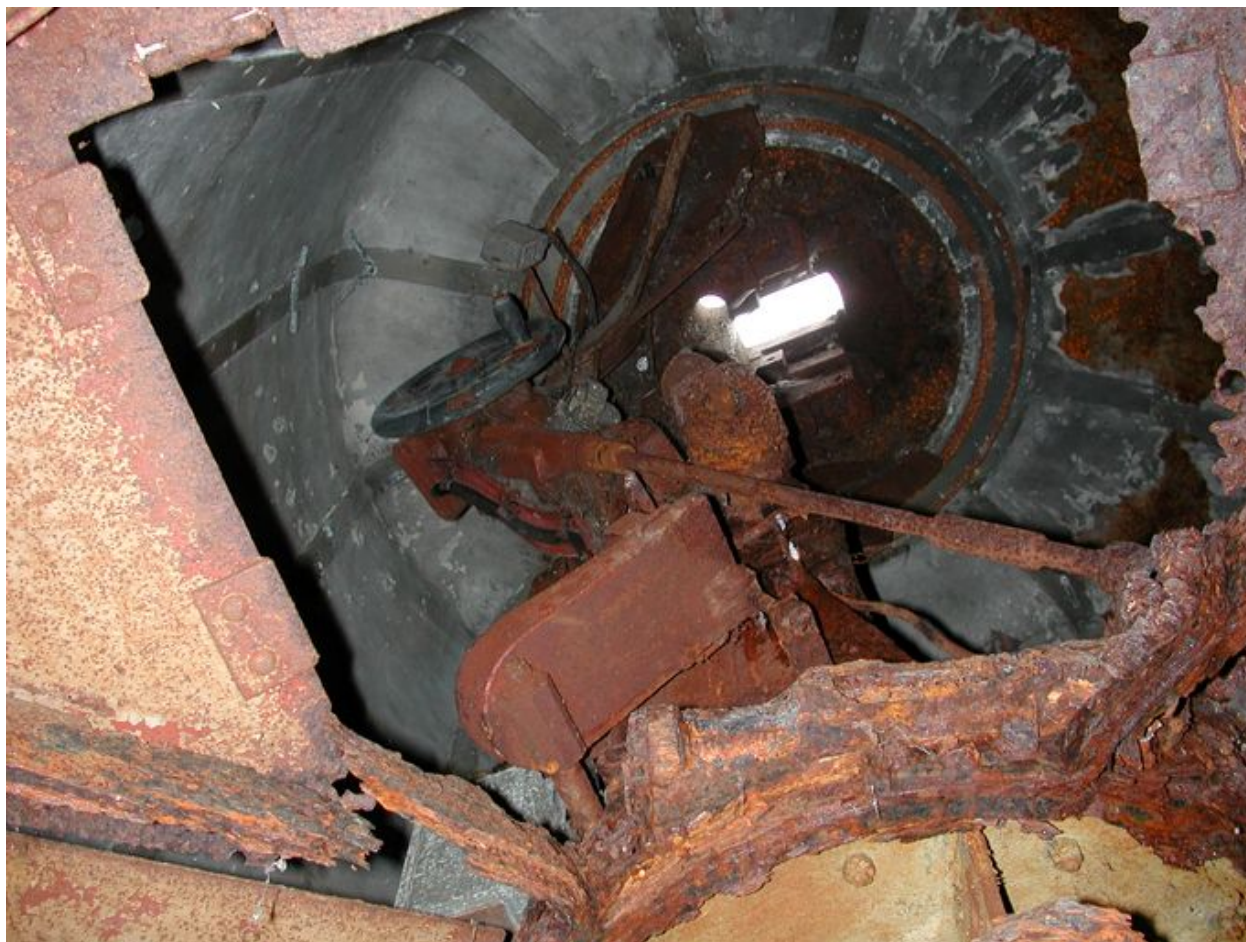
Vue intérieure : cloche blindée avec affût du mortier automatique (état en 2003)
