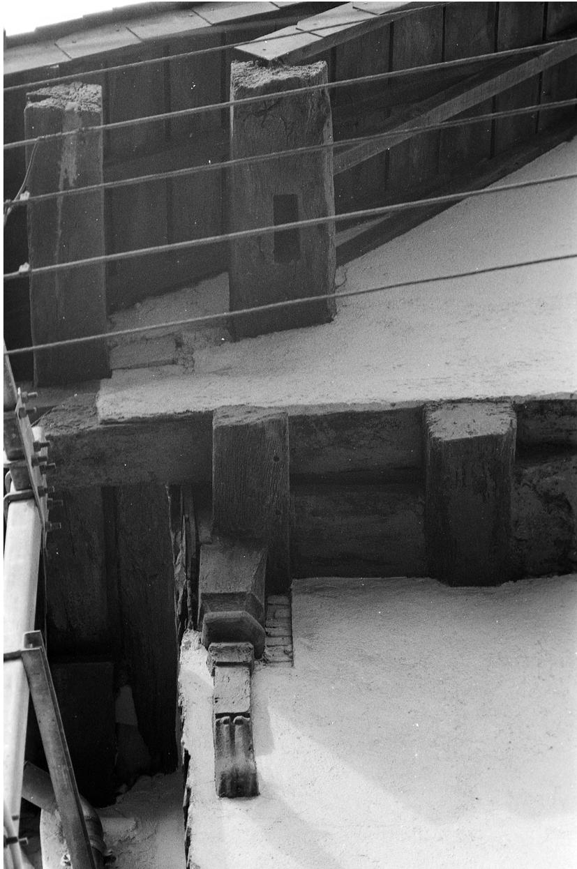
Détail de l'encorbellement au troisième étage, console et mortaise orpheline, état en 1974
