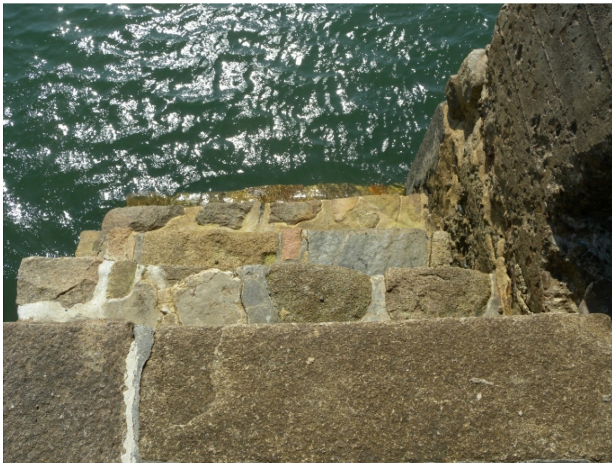
Vue de l'escalier à l'extrémité de la cale
