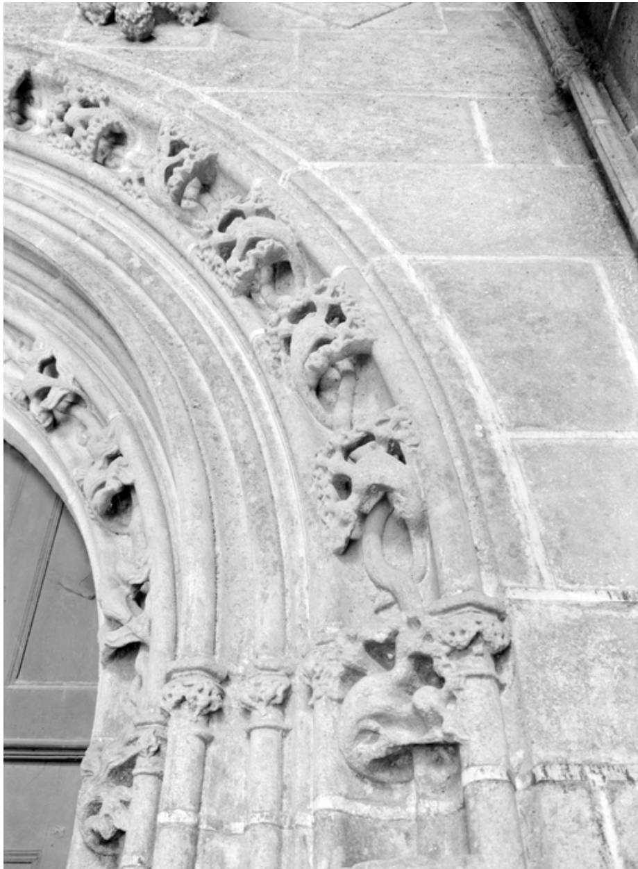
Porche sud de la nef, détail des voussures.
