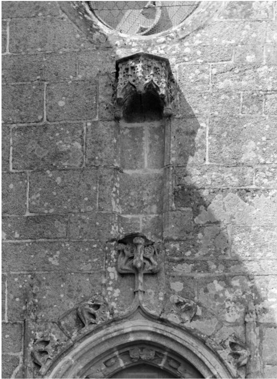
Niche du mur sud du choeur.
