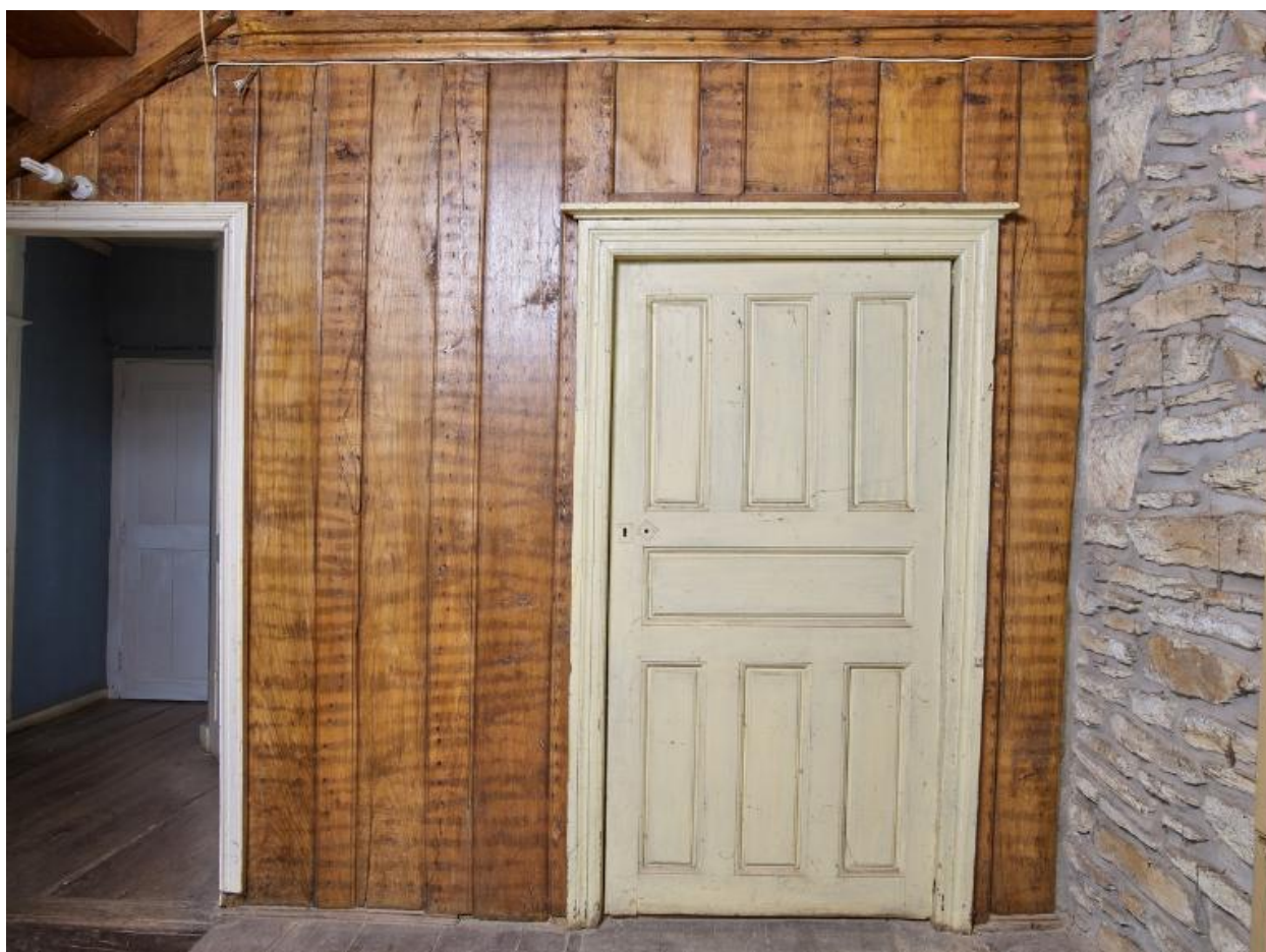
Logis. Palier du premier étage. Portes d'antichambre et de chambre
