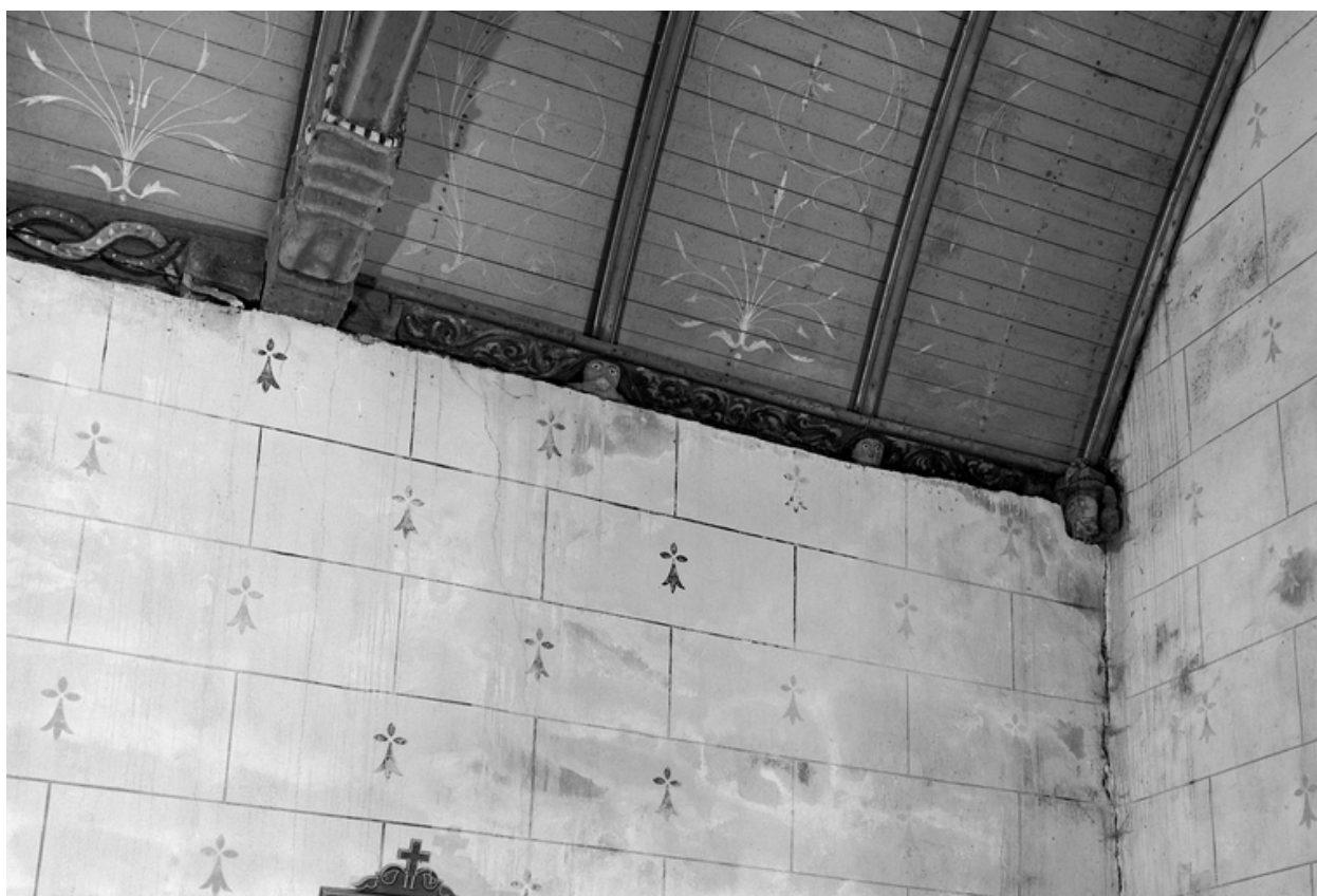
Croisillon nord, mur ouest, sablière, du sud au nord : 2ème motif
