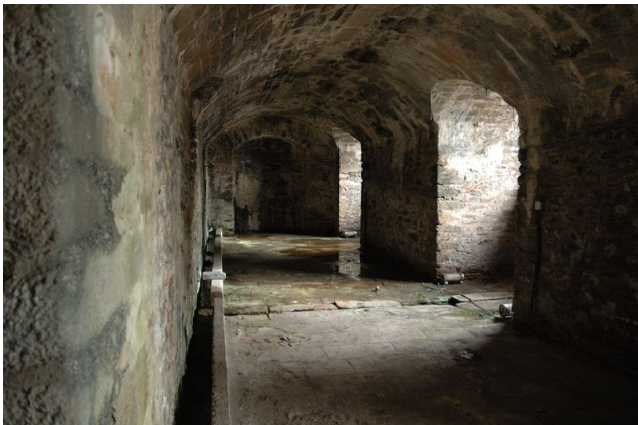
Vue intérieure : galerie voûtée du sous-sol
