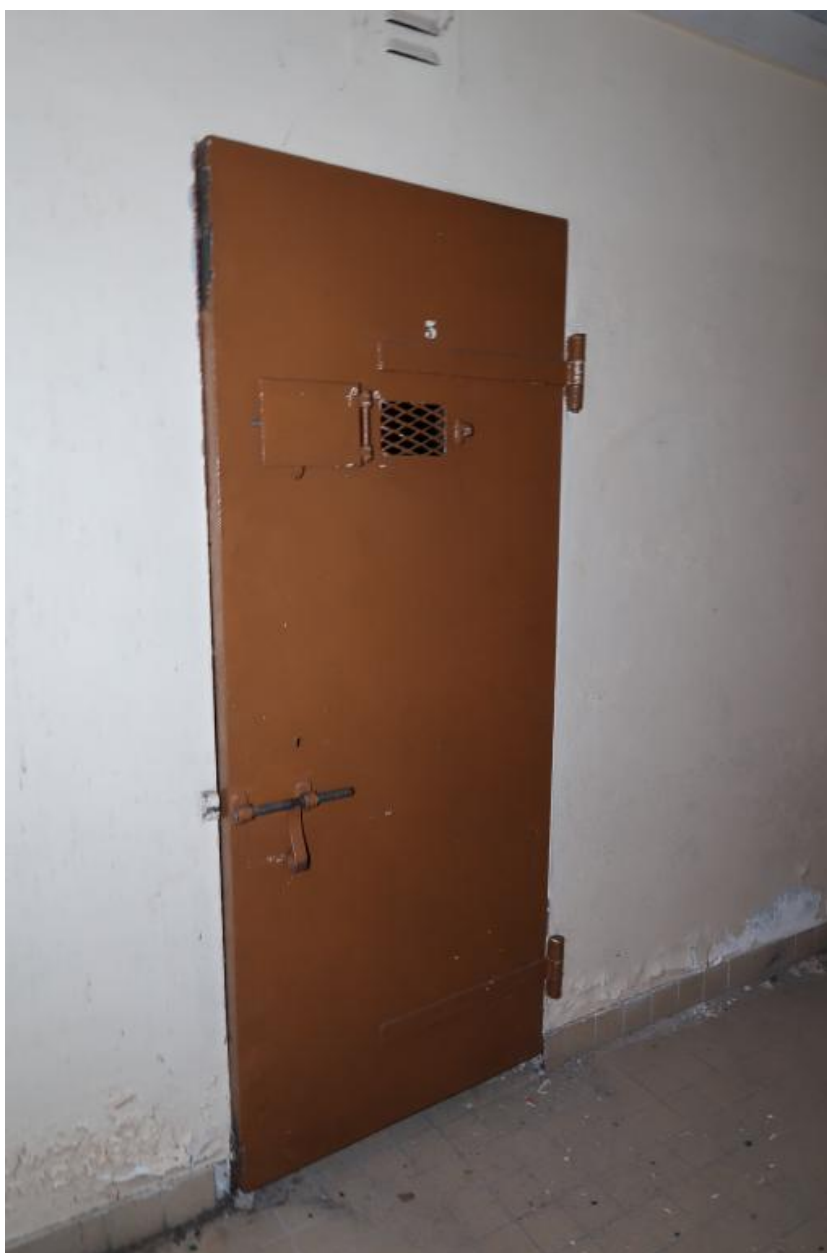
Vue de l'une des portes de cellule (état en 2022)
