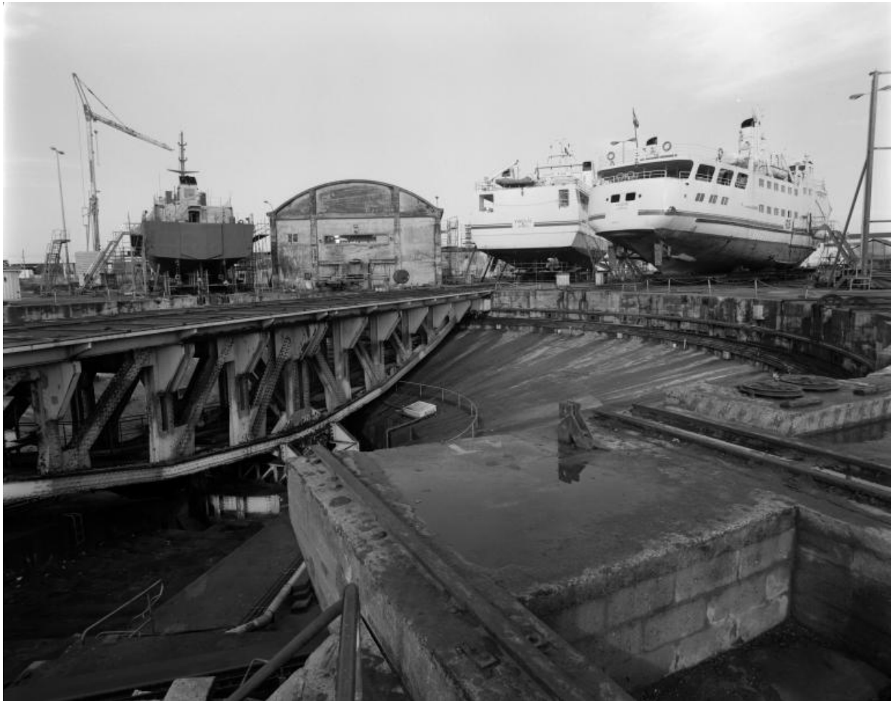
Vue du pont basculant et tournant en 2000. Au centre, le bâtiment abritant le treuil de hisseage principal du slipway
