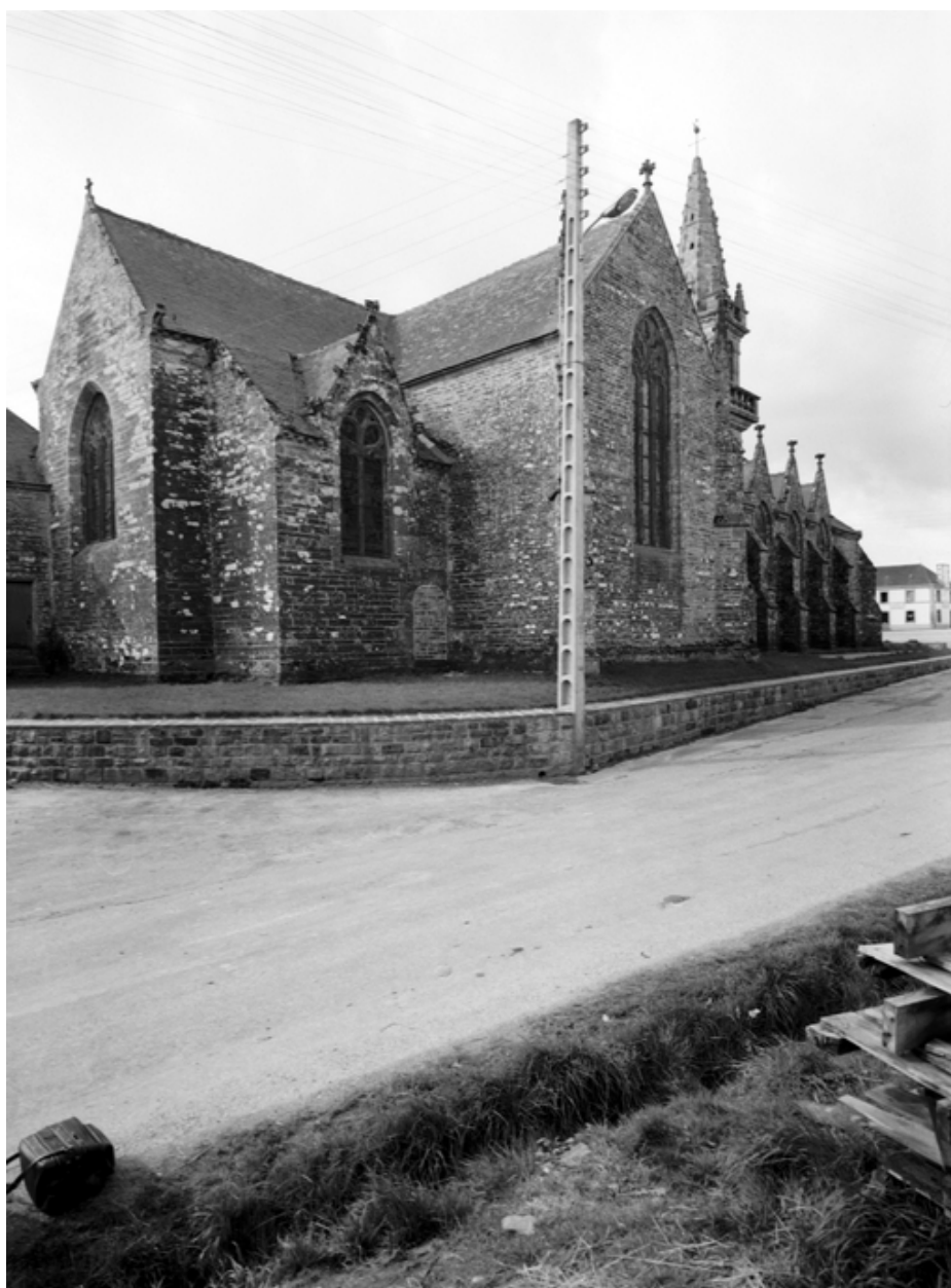
Façade nord et chevet
