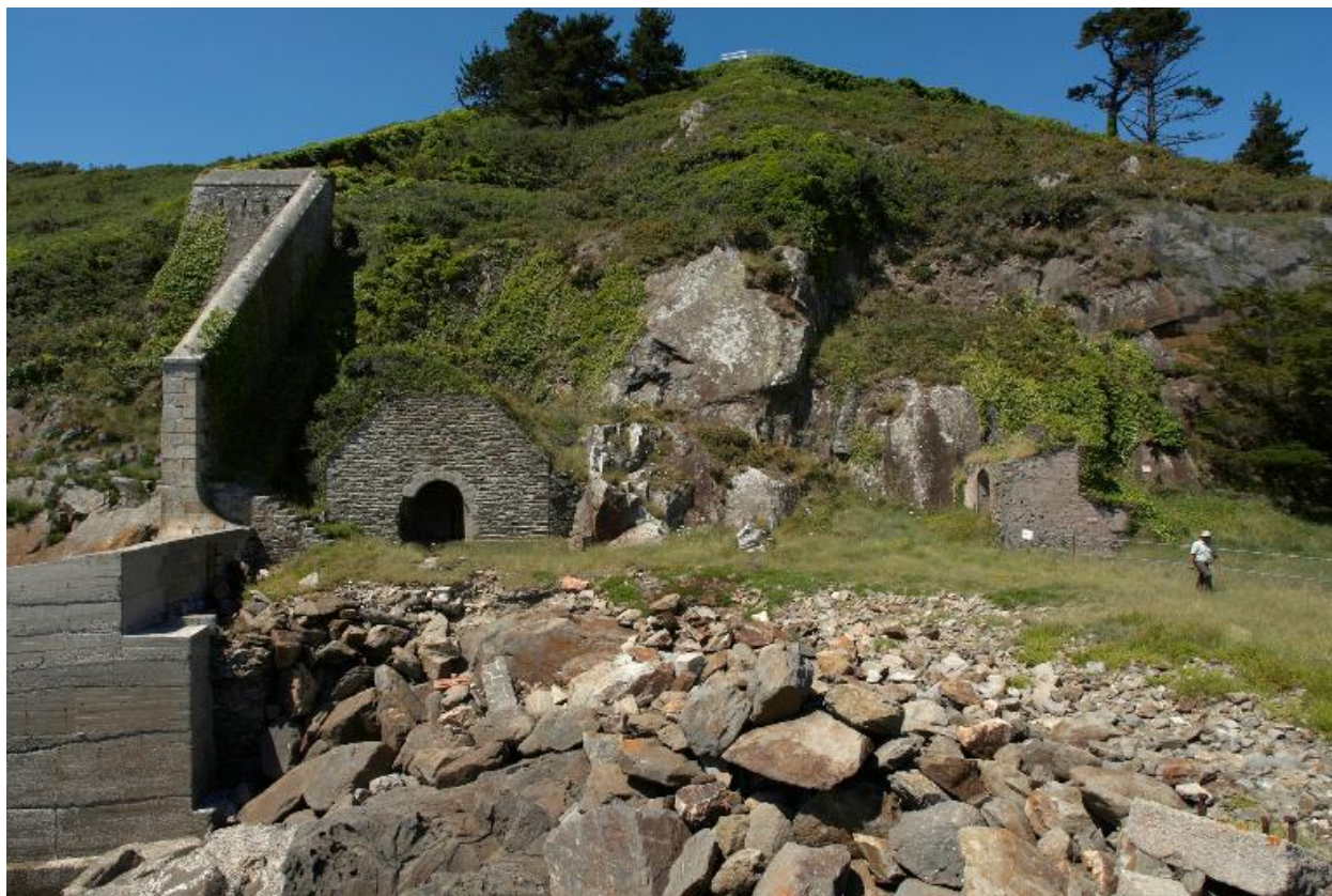
Plouzané : vue du fort du Mengant, abri de jour du projecteur
