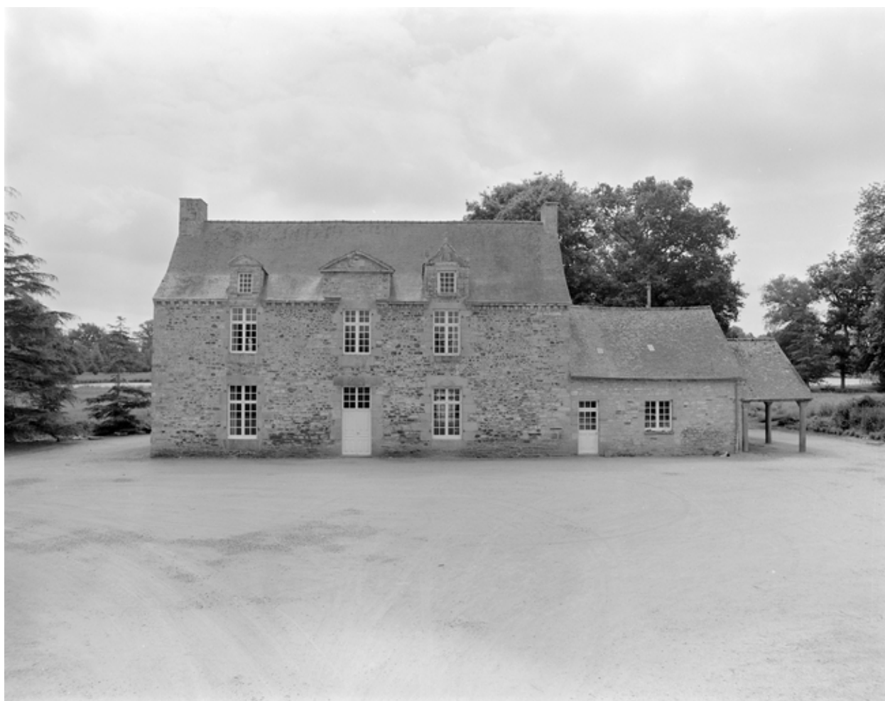
Vue générale façade nord
