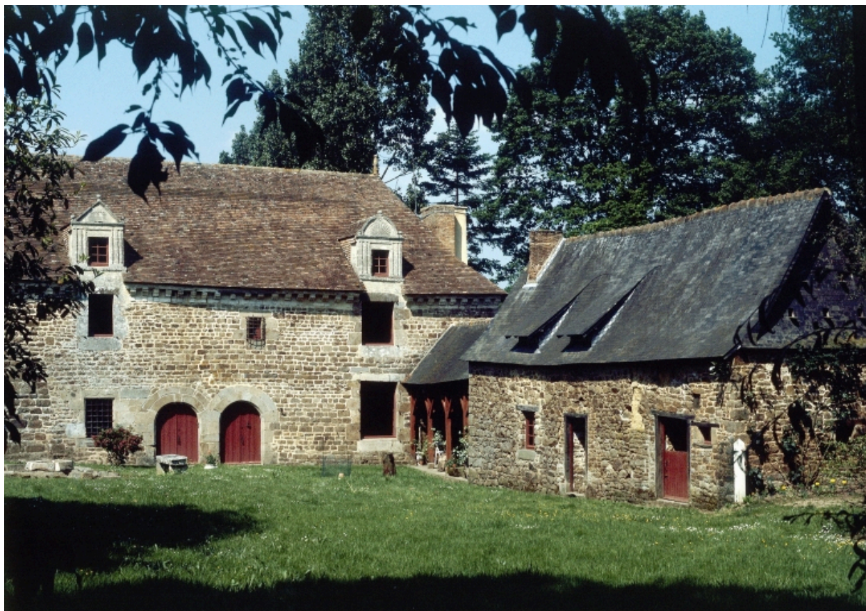
Façade principale et communs, vue générale.
