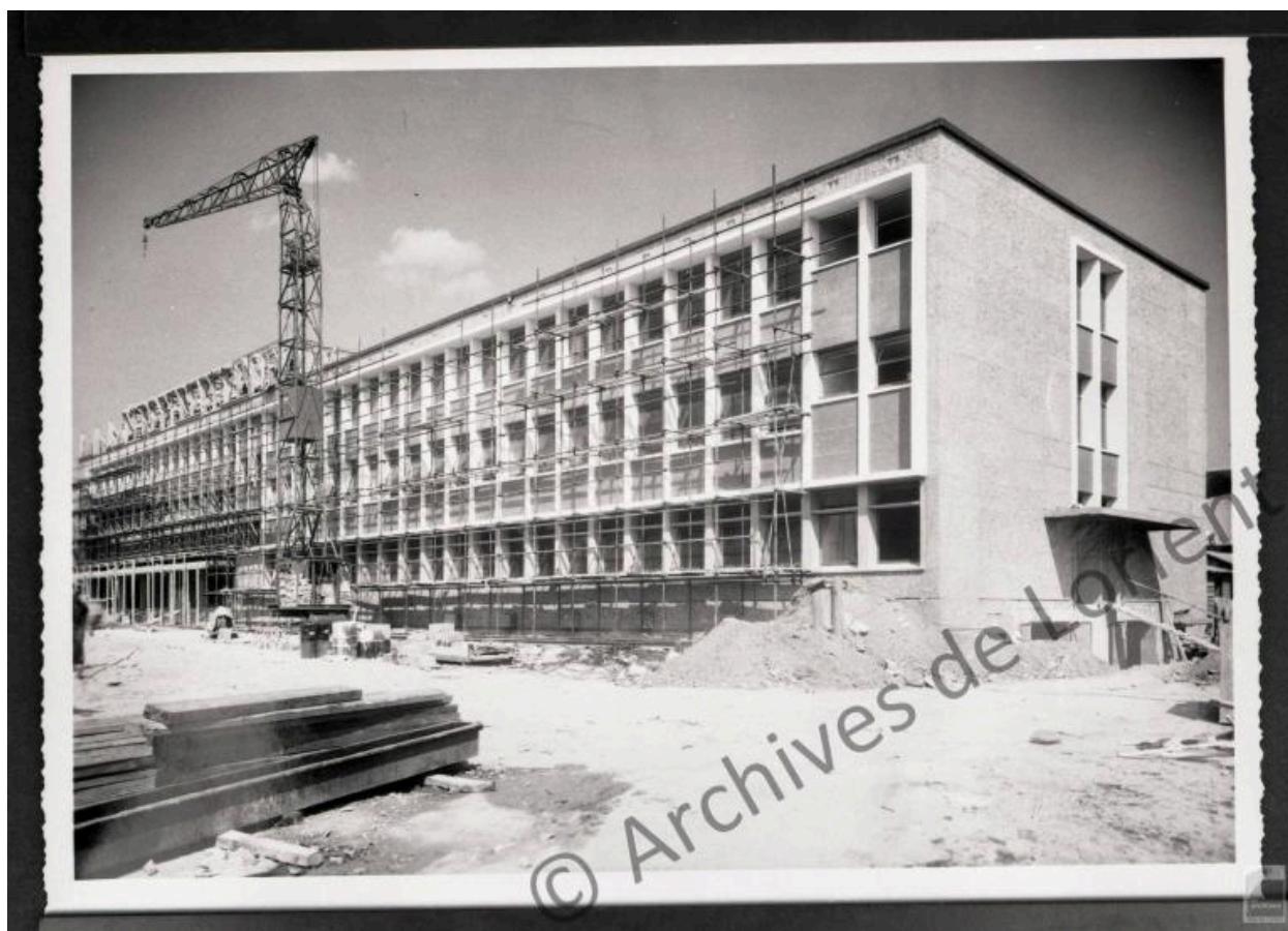
Construction du bâtiment scientifique (R. Ouvré, architecte). On remarque la construction du portique au dernier étage.
