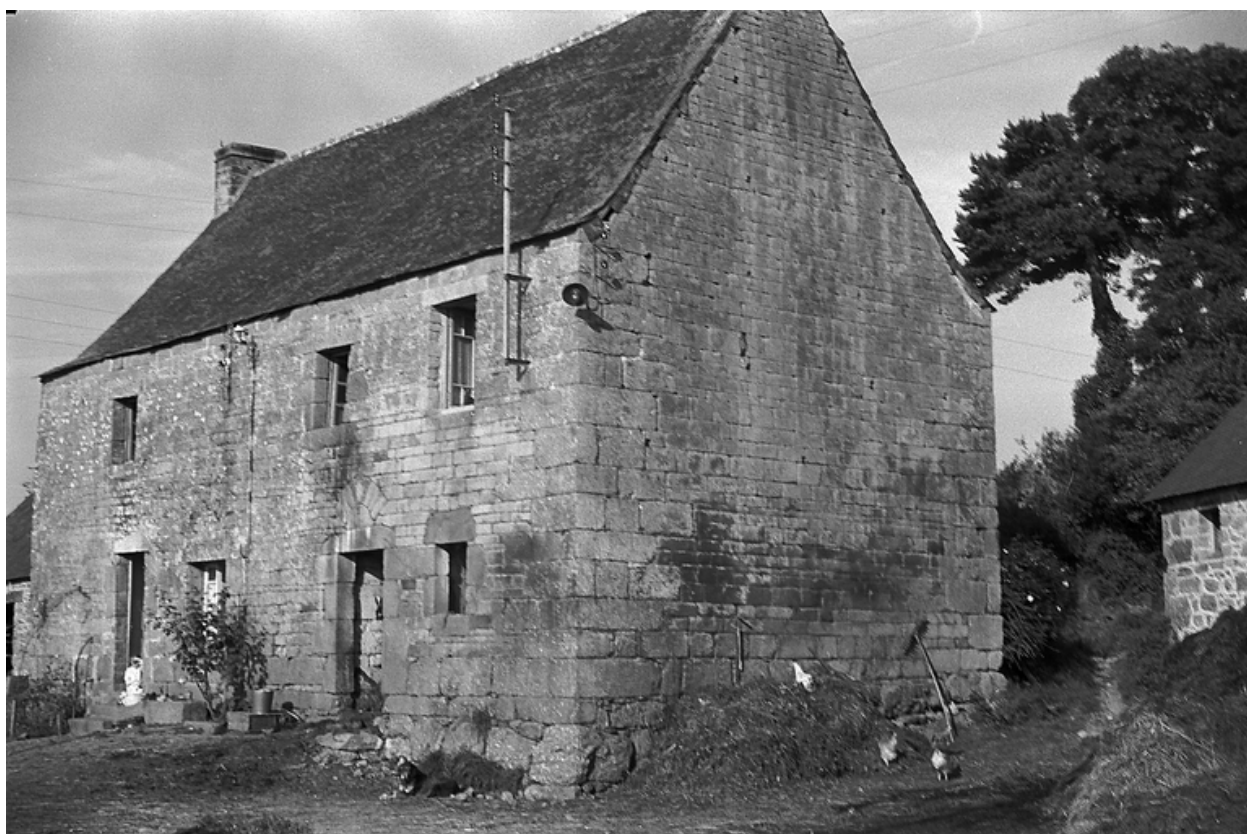
Elévation sud : vue prise du sud est
