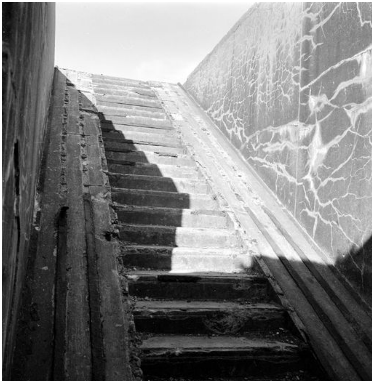
Vue du poste de direction de tir : escalier d'accès faisant rampe et entrée (état en 1969)
