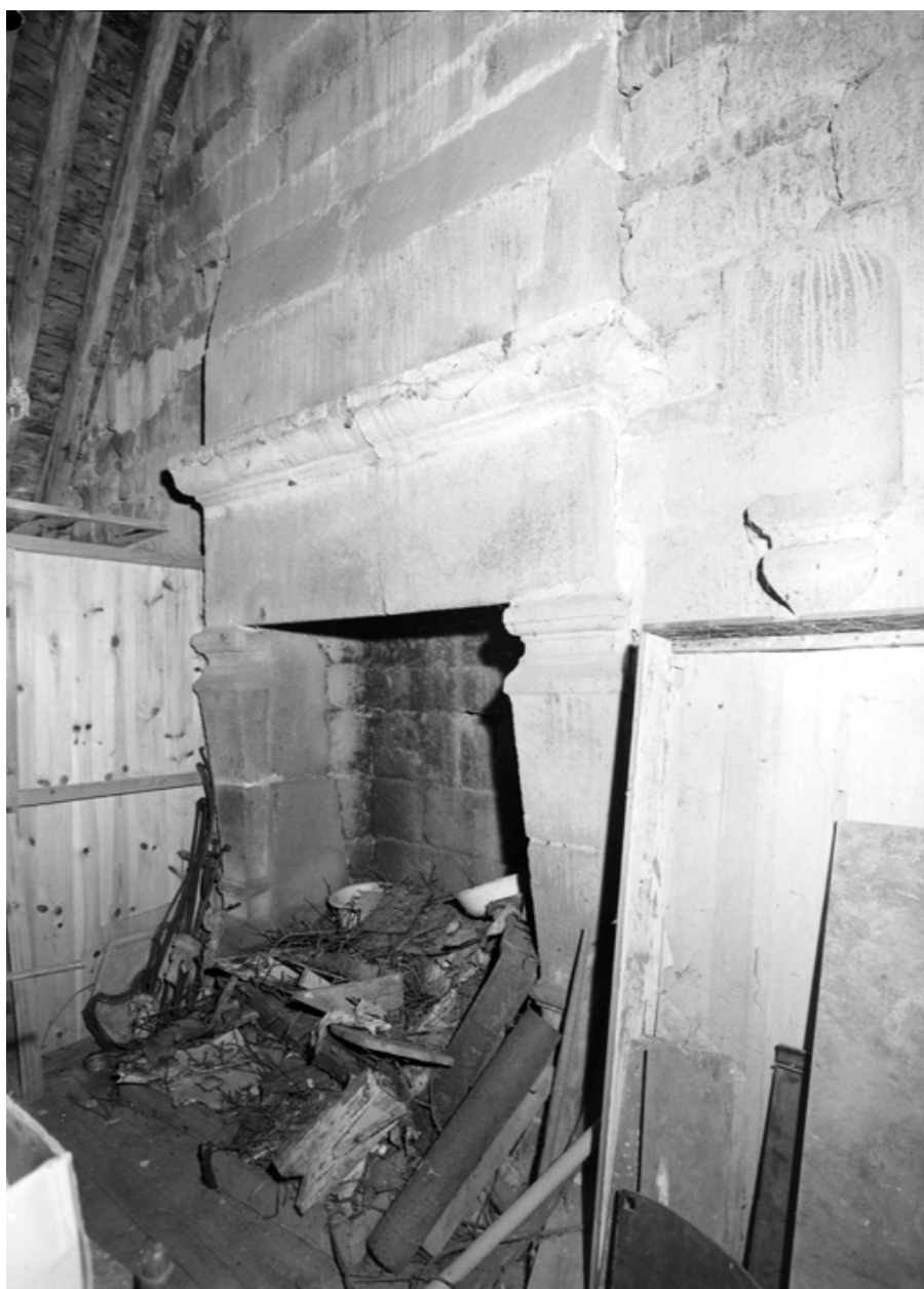
Combles nord du corps central : cheminée
