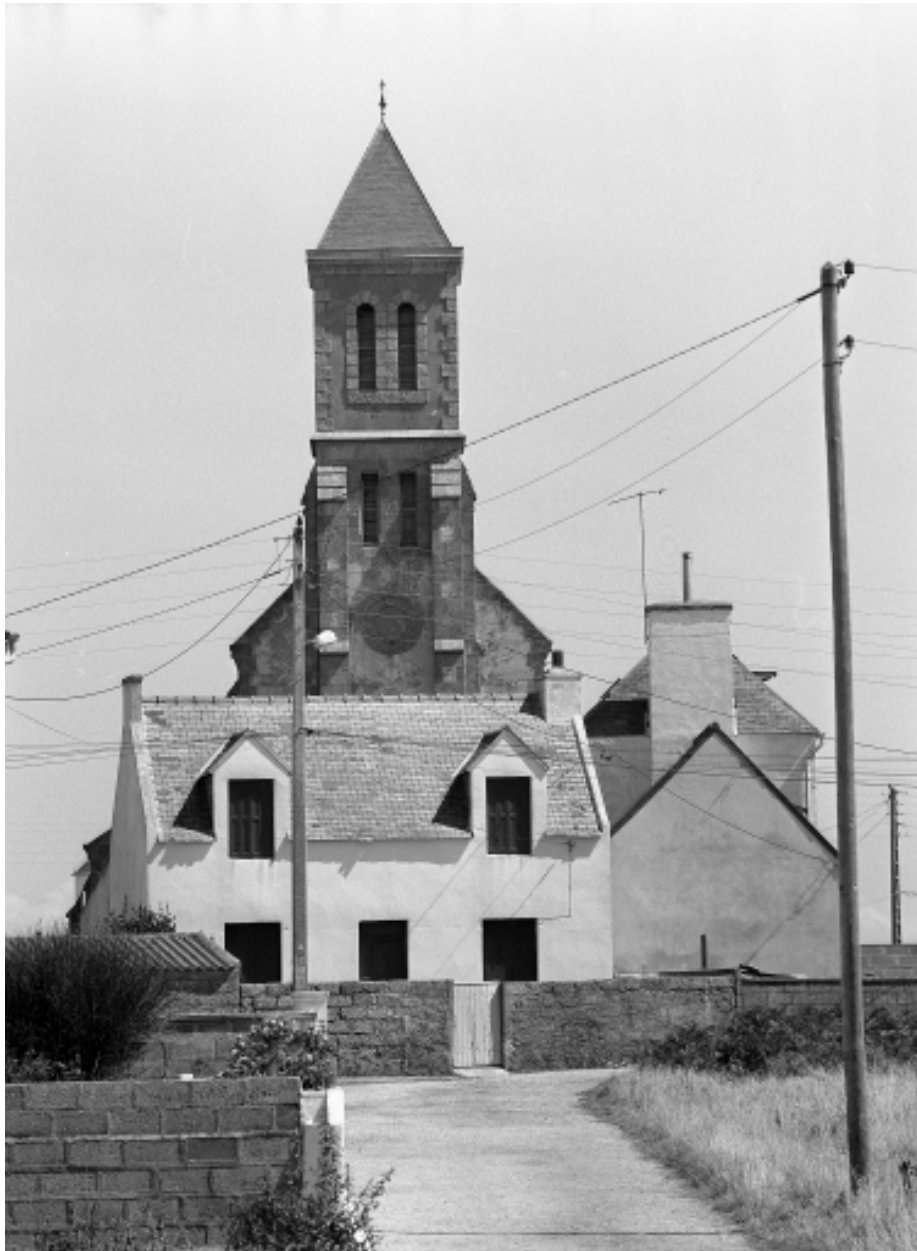
Ile-de-Sein, église paroissiale Saint-Guérolé : clocher, élévation ouest, état en 1986
