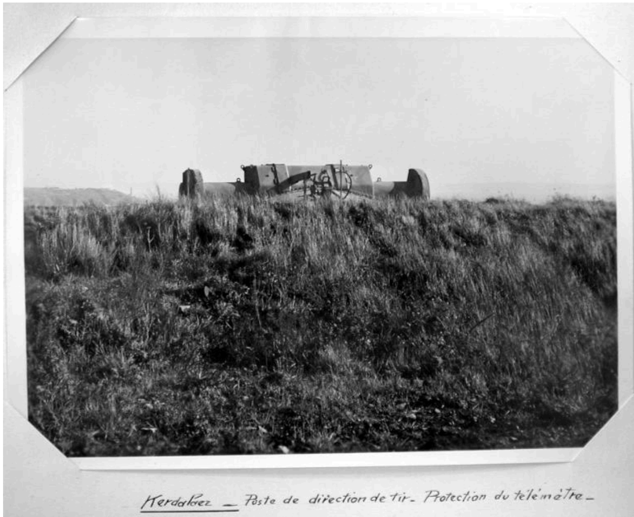
Vue du télémètre blindé du bunker-poste de direction de tir (extrait du Rapport Pinczon du Sel, 1946-1949)
