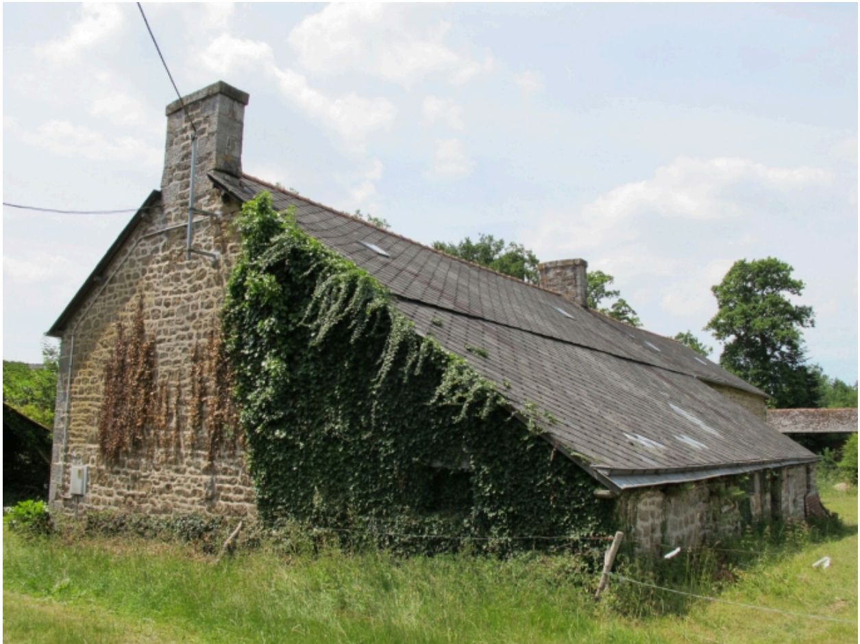
Vue arrière de la ferme
