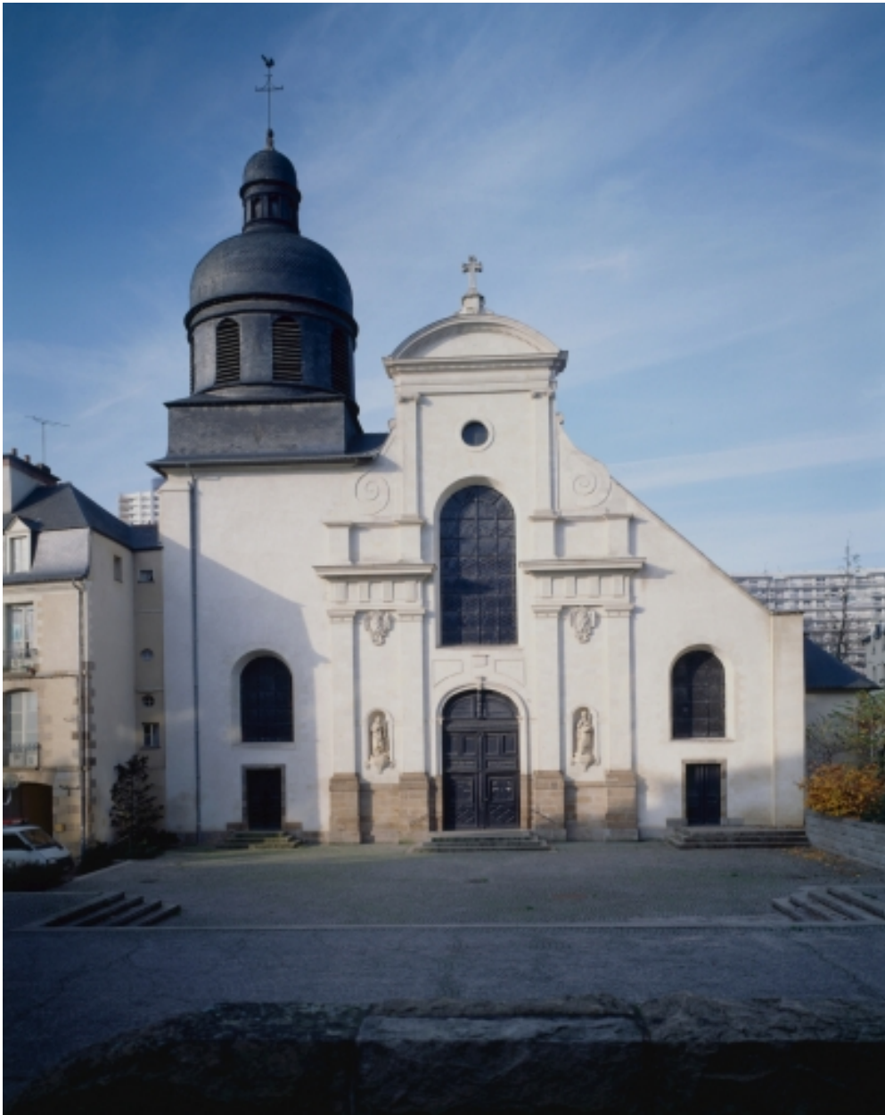
Elévation Est : vue générale
