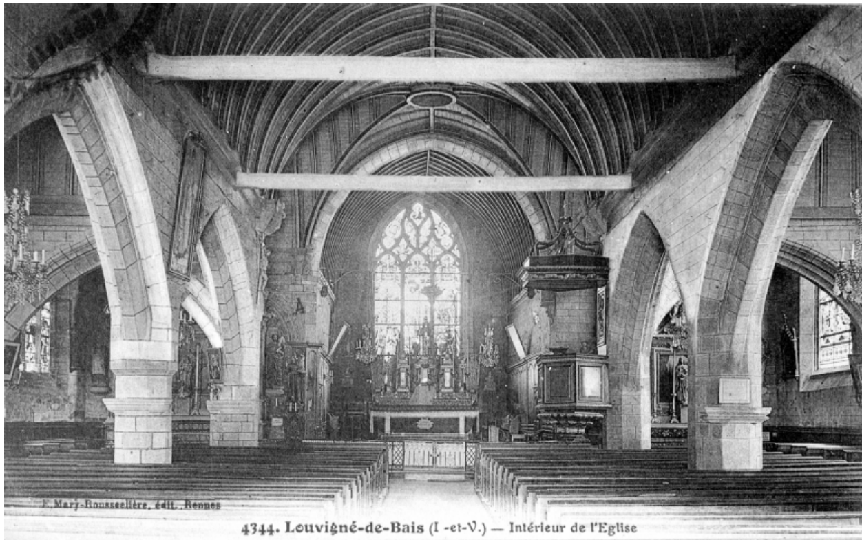
Carte postale ancienne - Intérieur, chœur : vue générale.
