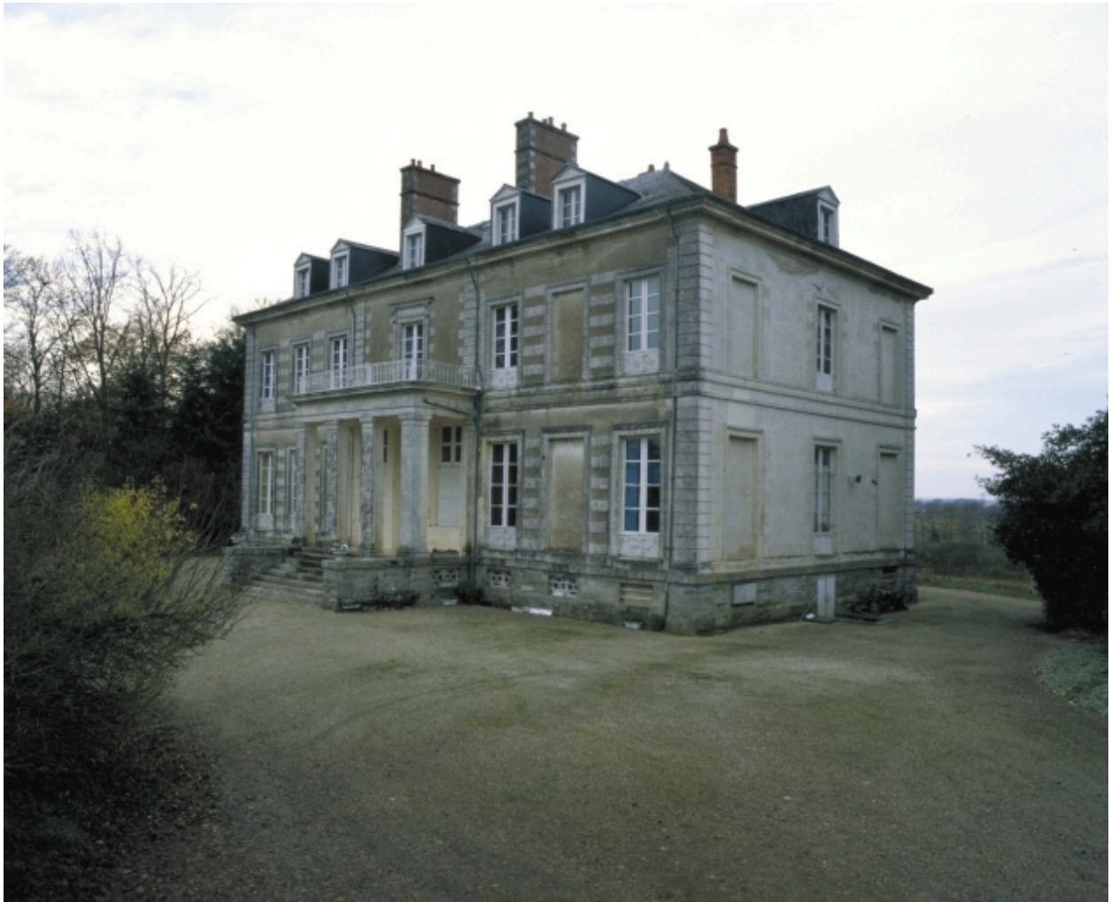
Vue générale sud-est : façade antérieure
