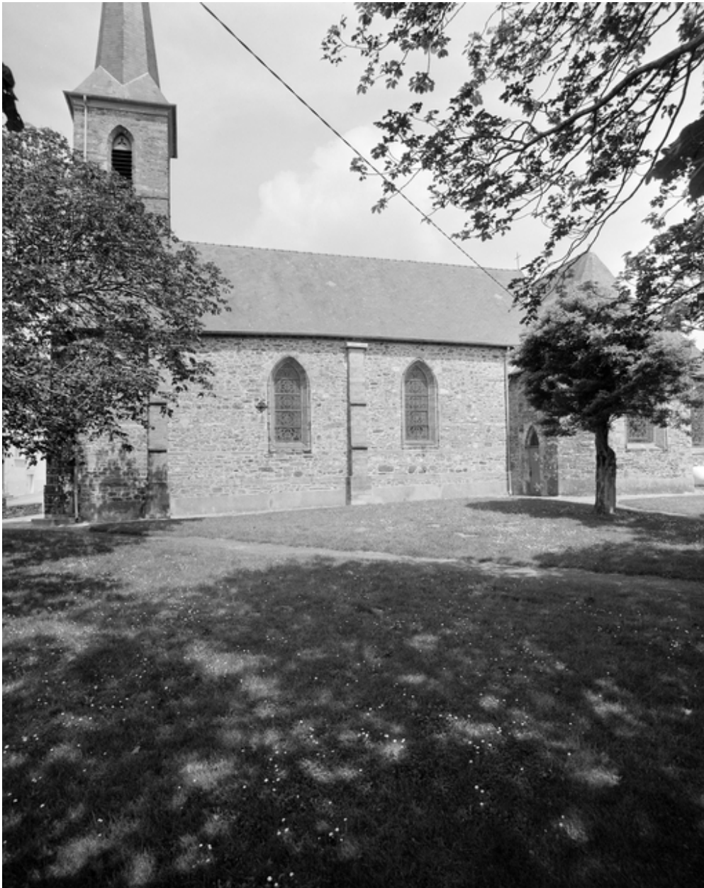
Le clocher : vue générale sud-est
